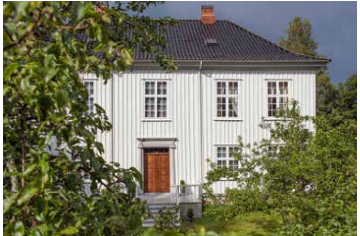
Hovedbygningen restaurert og tilbakeført til farger anno 1817. Fremdeles mangler gavlen som før 1900 kronet taket i front.
